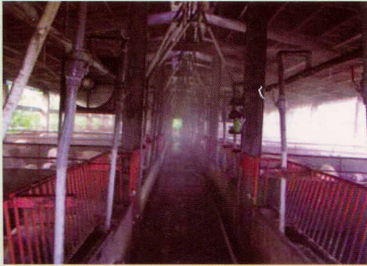
圖 1. 自動化畜舍消毒設備。
