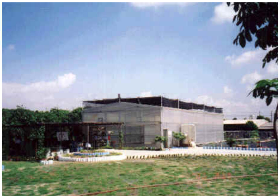
照片 1 善化公司園藝設施高壓噴霧降溫系統設施全景
