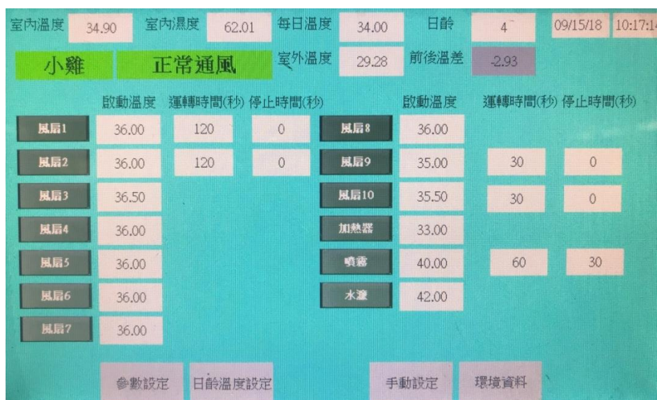
圖 30、雞舍現場環控系統主畫面
