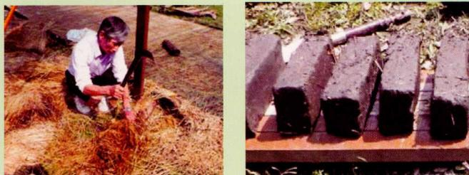
圖 10. 以黏土、牛糞、稻草加水搗成泥漿製成土角
