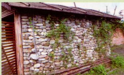
圖2. 多孔隙的石牆
