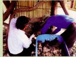
圖 11. 土角砌成所需的土角牆並將泥糊到土角牆的牆面
