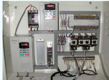
圖13、控制箱內部配置之可程式控制器及可程式變頻器
